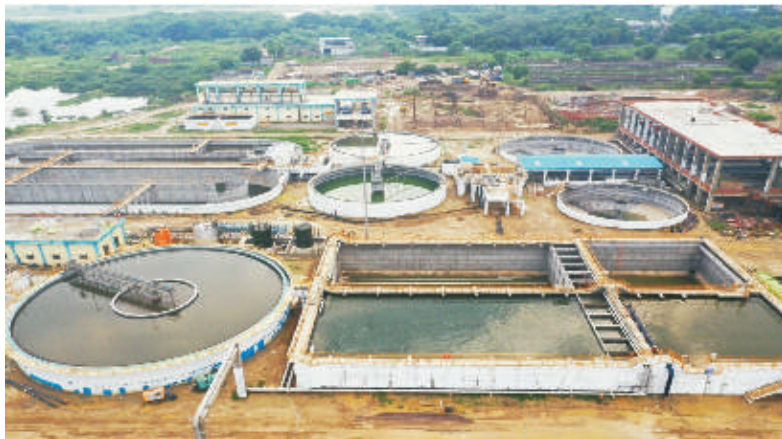
Jajmau CETP 20 MLD
