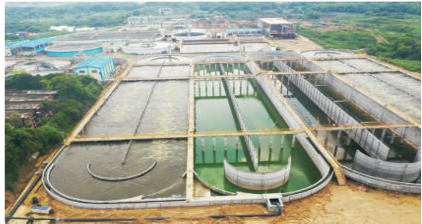
Jajmau CETP 20 MLD
