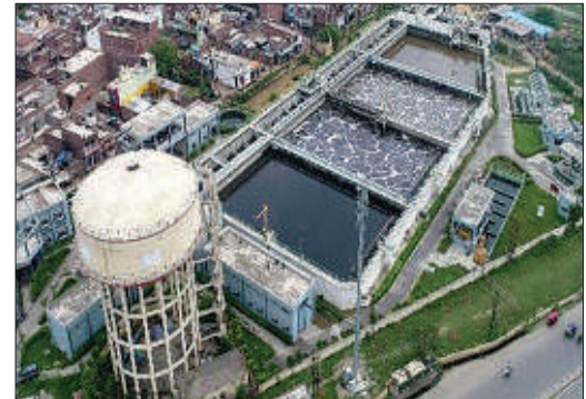
Moradabad 58 MLD NJK (STP)
