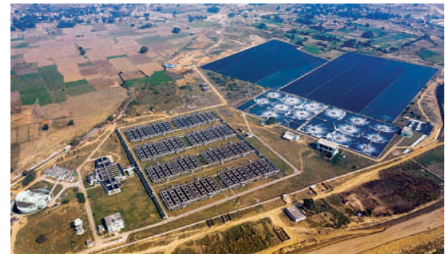
210 MLD STP Bhingawan. Kanpur
