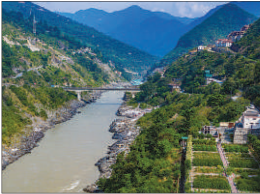
Devprayag 1.40 MLD NJK (STP)
