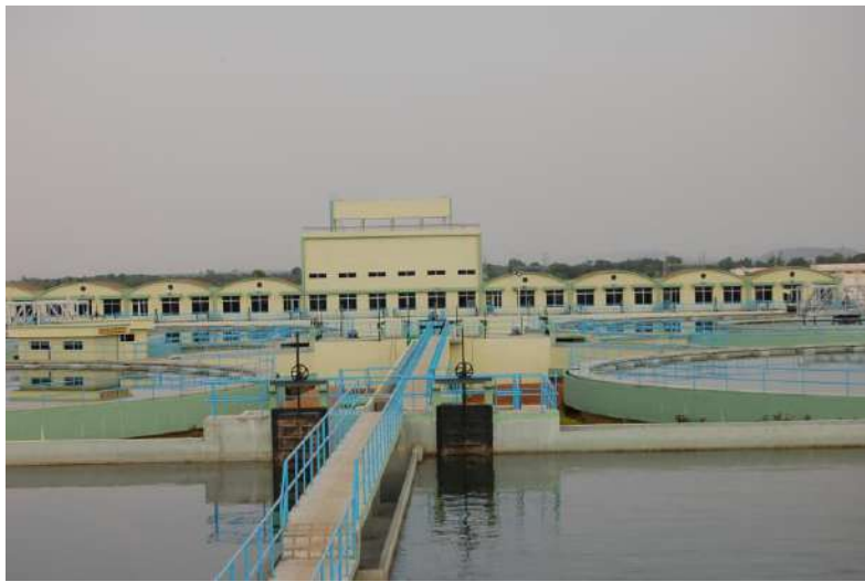
410 Mld WTP - Kodandapur
